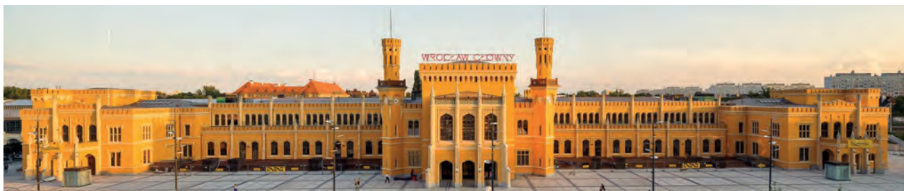
25. Widok fasady po zakończeniu prac konserwatorskich, 2012 r.
